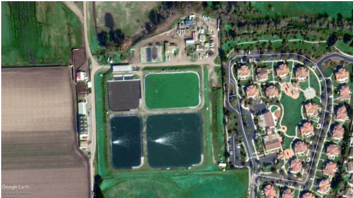
Figura 9-2 Planta de tratamiento de aguas residuales de Guadalupe
