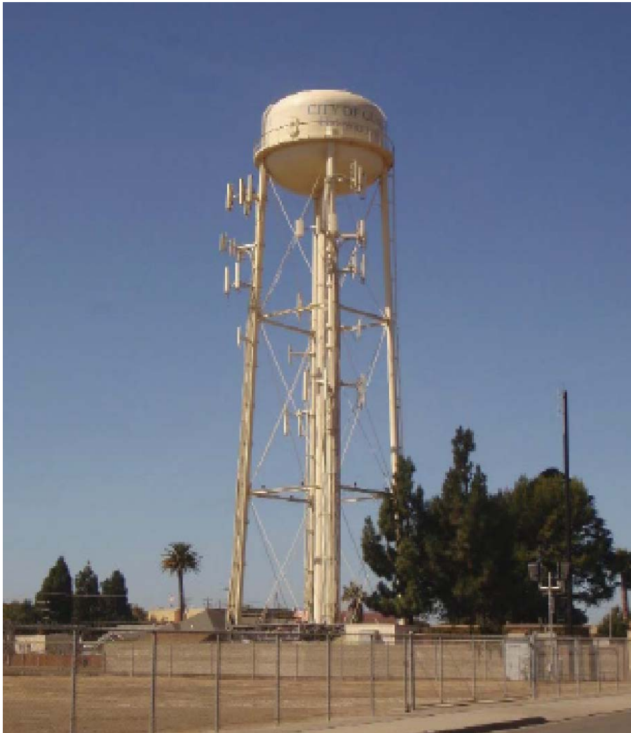
Figura 9-1 Tanque de agua elevado en Pacheco y 10 th Street
