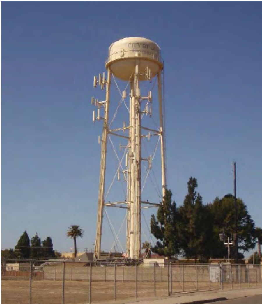
Figura 9-1 Tanque de agua elevado en Pacheco y Calle 10
