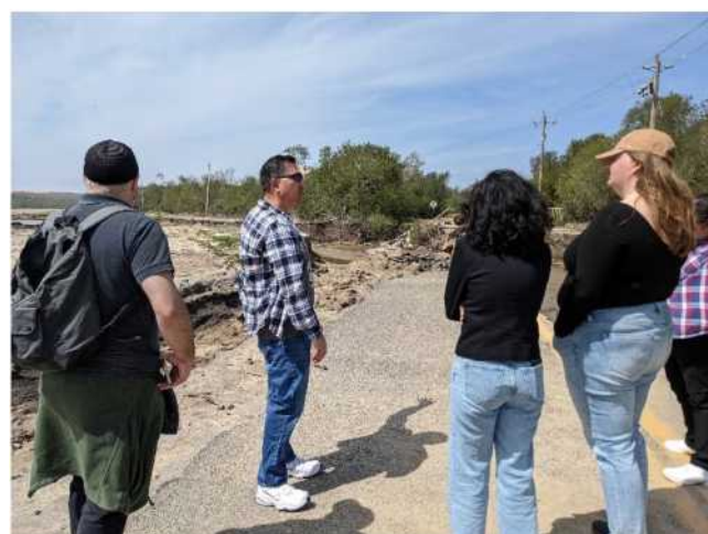
Observación de los daños causados por las inundaciones en West Main Street, cerca de las dunas, durante la visita a la comunidad (crédito: Megan McConville).
